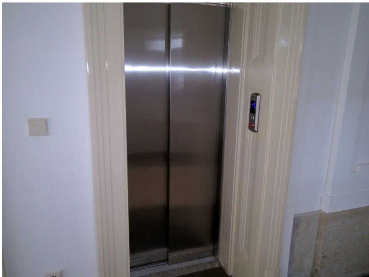
Foto č. 2 Pohled na vstup do výtahu
