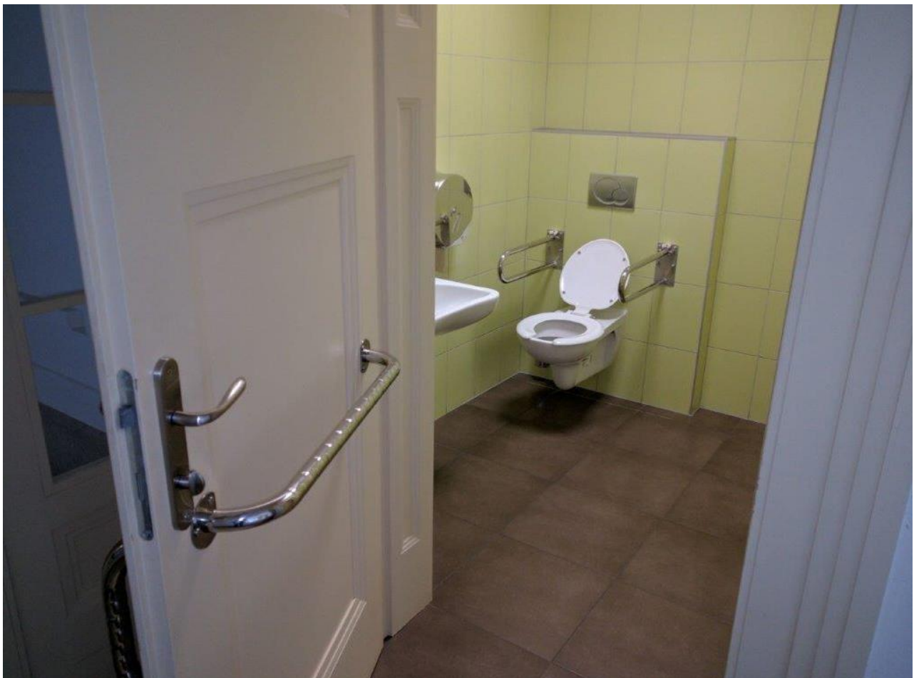
Foto č. 6 Pohled do prostoru bezbariérového WC
