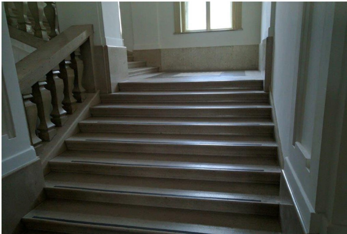
Foto č. 1 pohled na vnitřní schodiště a podestu
