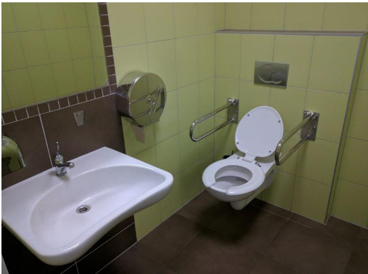
Foto č. 7 Pohled do prostoru bezbariérového WC
