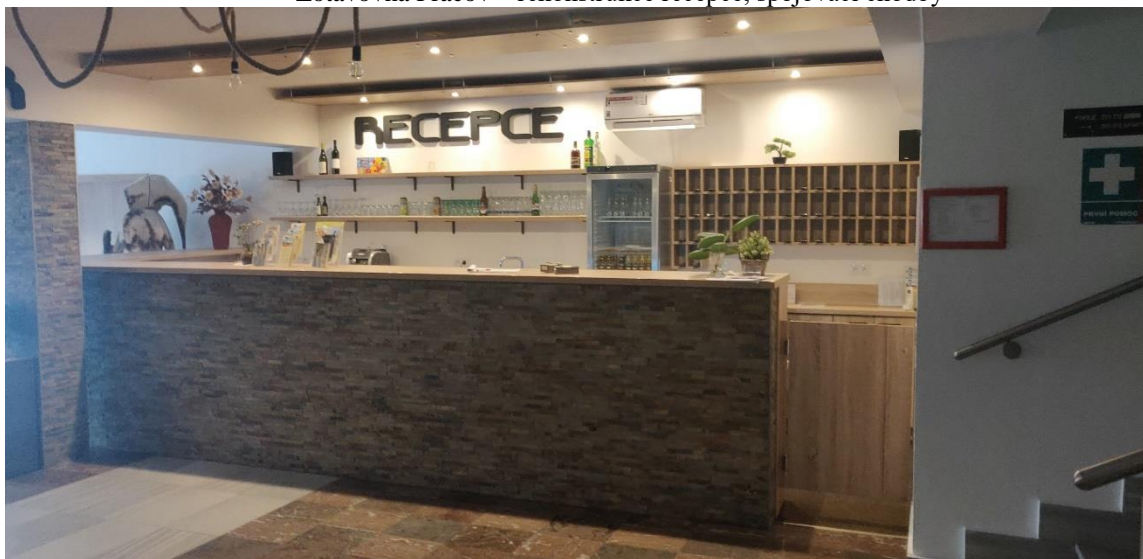
Zotavovna Pracov – rekonstrukce recepce, spojovací chodby
