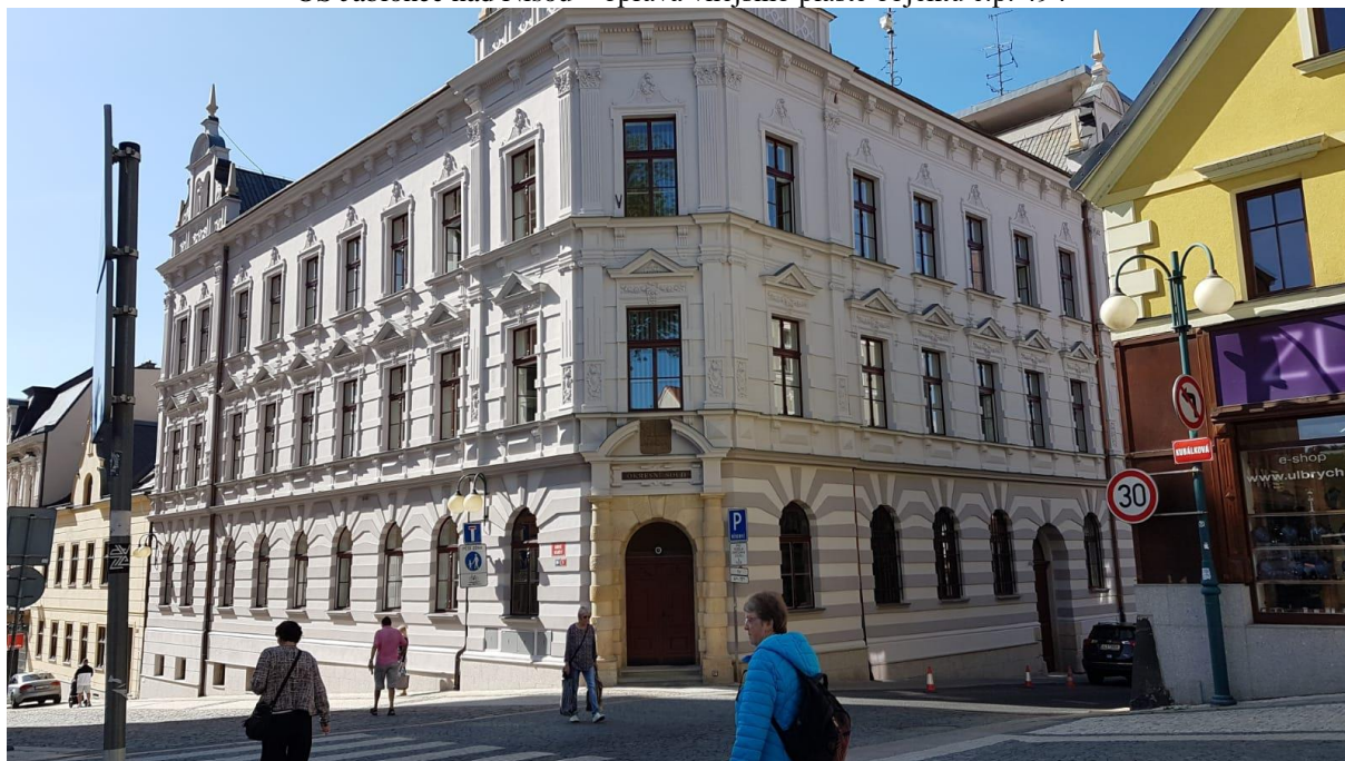
OS Jablonec nad Nisou – oprava vnějšího pláště objektu č.p. 494
