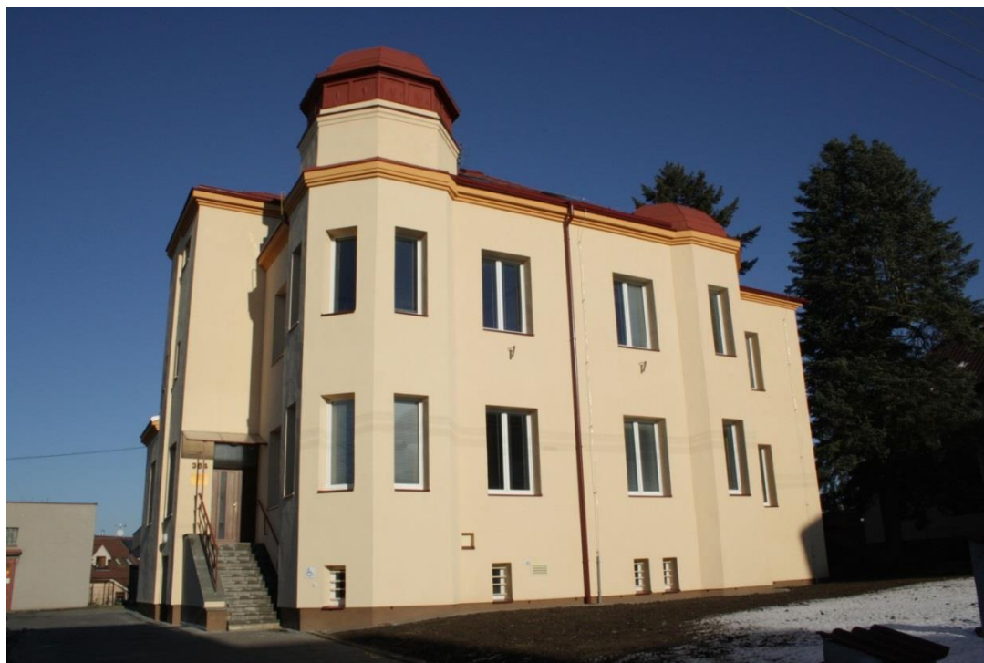
OSZ Chrudim – zateplení a oprava fasády
