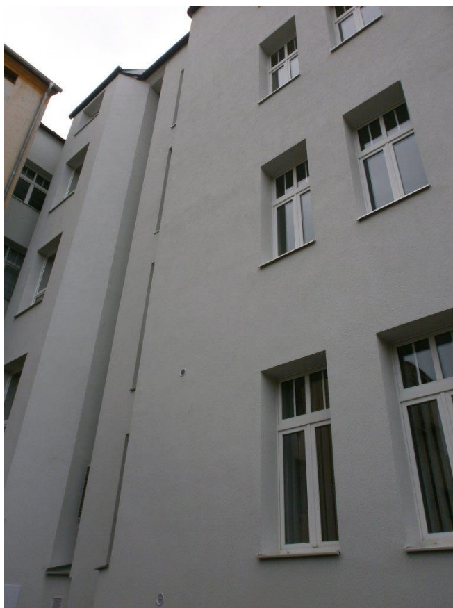
OSZ Cheb – výměna oken a zateplení fasády
